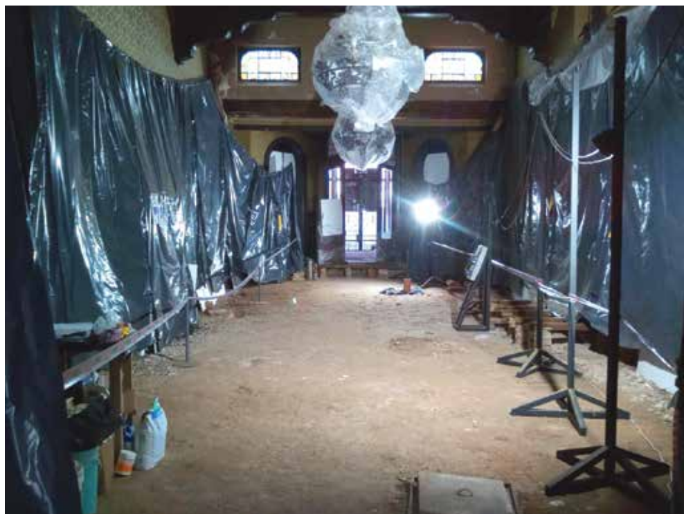
Trabajos de restauración del piso de la sala central del Museo Estevez
